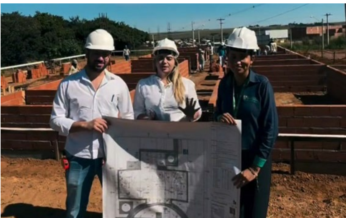
Santo Antônio da Barra está construindo uma nova unidade básica de saúde — Foto: Reprodução.
